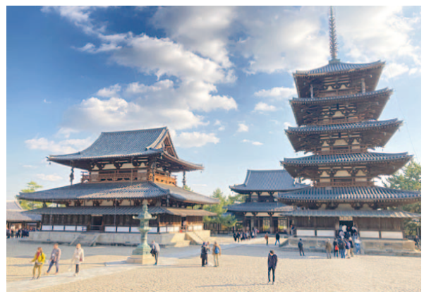
図4 (b) 法隆寺 金堂と五重塔
